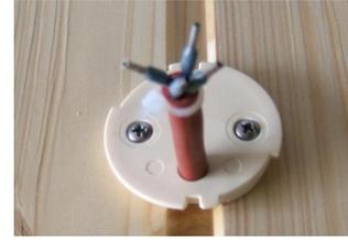
1. Wärmebeständige Signalleitung für den Fühler durch die vorgesehene Leitungsdurchführung und durch die Bohrung der Befestigungsplatte führen.
